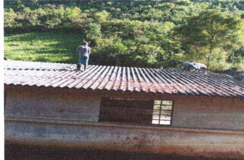
CAMBIO DE VENTANA Y VIDRIO, Y CAMBIO CUBIERTO DE LAMINA
