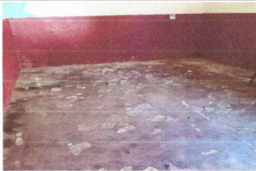
SUSTITUCION DE PISO
