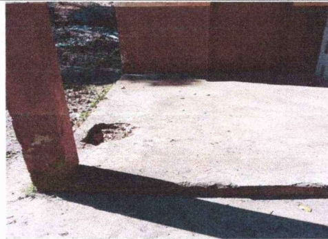
LOSA DE PATIO
