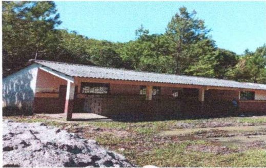
CAMBIO DE ESTRUCTURA DE MADERA POR METAL Y CUBIERTO DE LAMINA Y SUSTITUCION DE PUERTAS DE METAL
