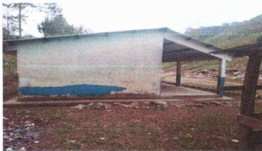
PINTURA DE MUROS INTERIO Y EXTERIOR
